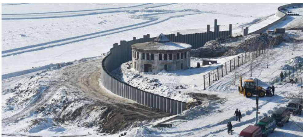
Строительные работы на набережной
